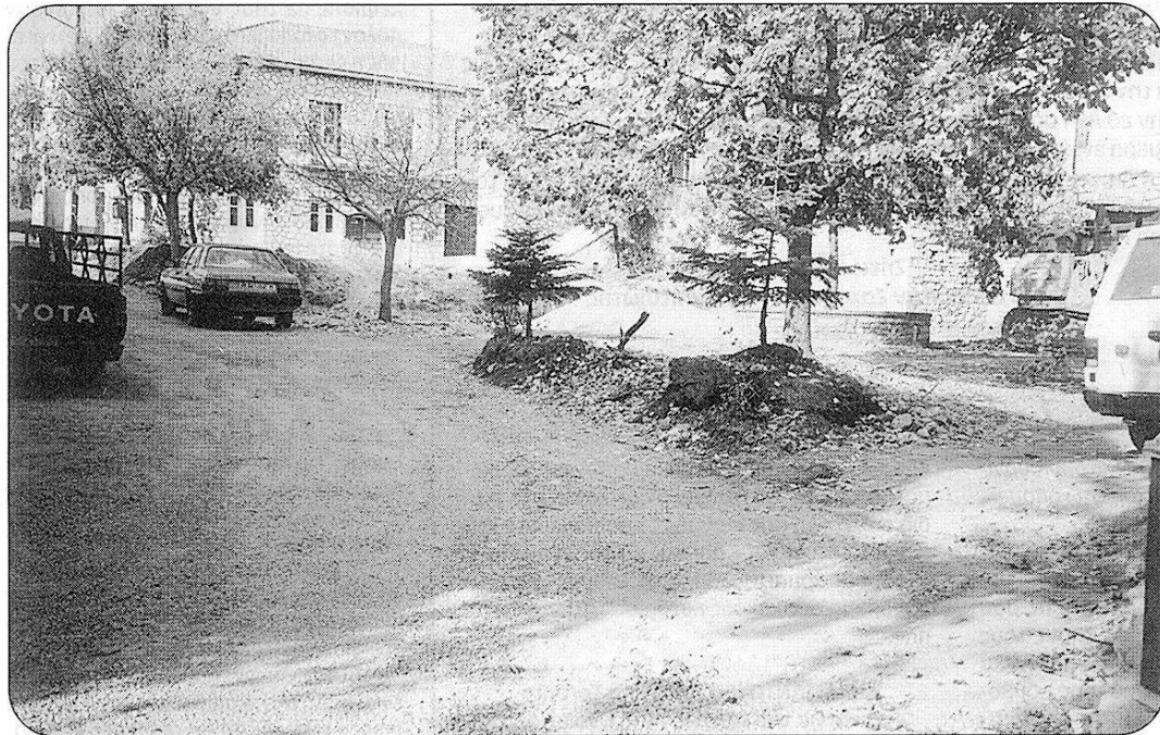
Καρυές: Η πλατεία του Αγίου Ανδρέα ανασκαμμένη περιμένει τη διαμόρφωσή της σύμφωνα με το αρχιτεκτονικό σχέδιο και κατά τις προβλέψεις των κατασκευών θα είναι έτοιμη αρχές Ιουνίου. Πάντως, η πλακόστρωση του δρόμου γίνεται με αριστοτεχνικό τρόπο, και τα μάρμαρα κάτω από τον πλάτανο γίνονται πολύ ωραία (πελεκητά).
